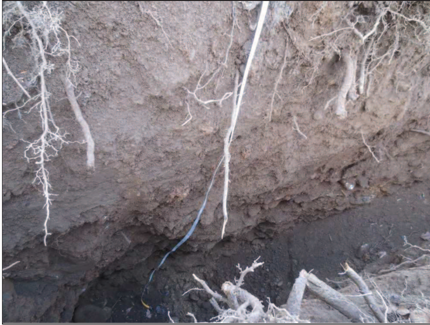
Figura 4.2 – Foto scavo esplorativo, porzione NE.
